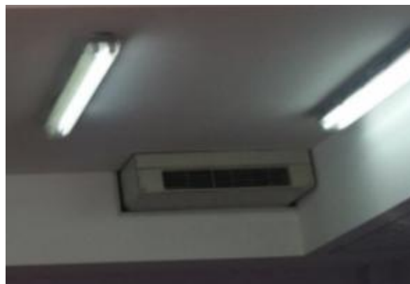
Fig 11. Fan coil pa termostat
