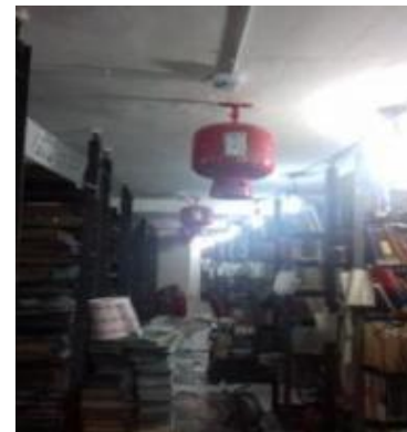
Fig 4. Fikese zjarri automatike jashte normave
