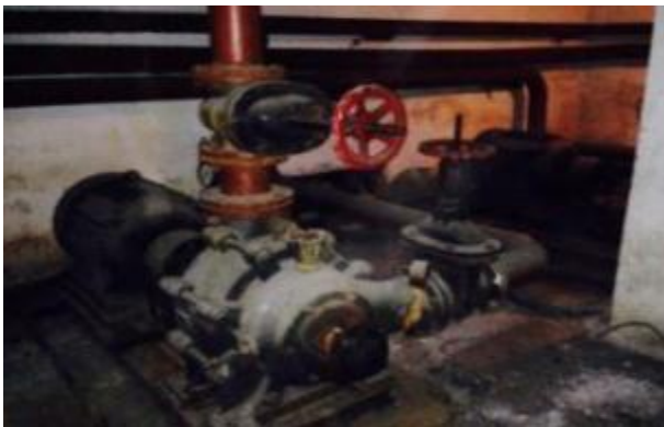
Fig 3. Stacioni egzistues I pompimit jashte normave
