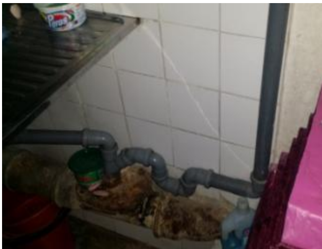
Fig 8. Tuba shkarkimi ujrave te zeza, material dhe teknika te vjetra
